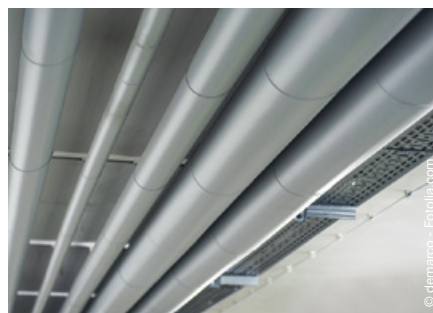
Montage de tubes
