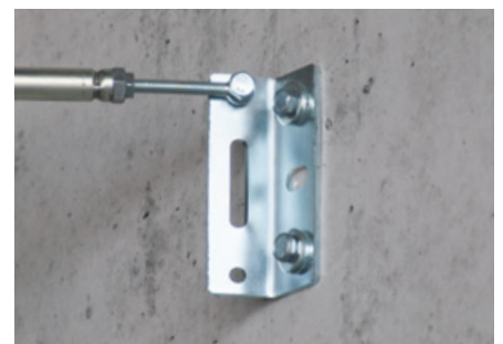
Fixation de supports muraux et de consoles
