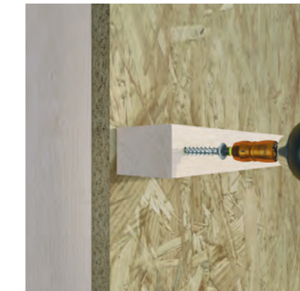
Fixation d'un niveau d'installation
