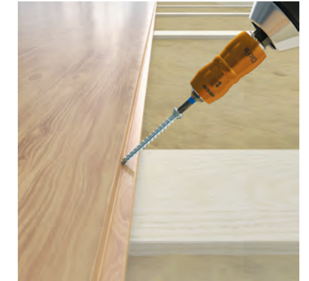
Fixation de revêtements de plancher
