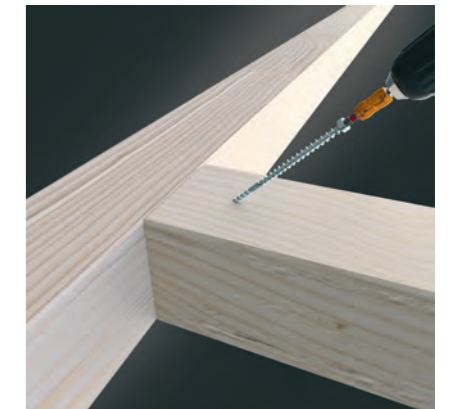
Assemblage poutre principale/secondaire
