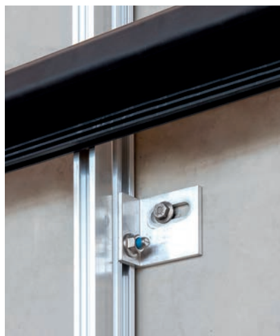
Fixation directe sur béton
